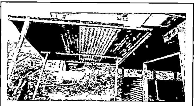
Foto 4: Sustitución de lámina por lámina troquelada de aluzinc calibre 26, 25 metros cuadrados.
