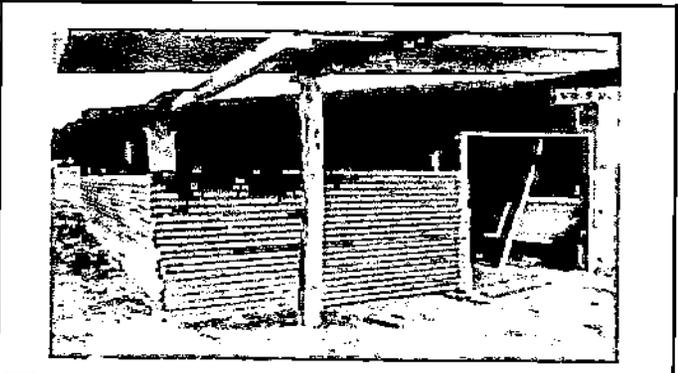
Foto 3: Sustitución de estructura de soporte de madera por metal, 25 metros cuadrados.
